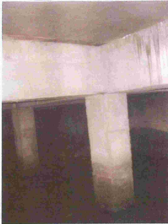
Fot.3 WIDOK WNEŹRZA SCHRONU
