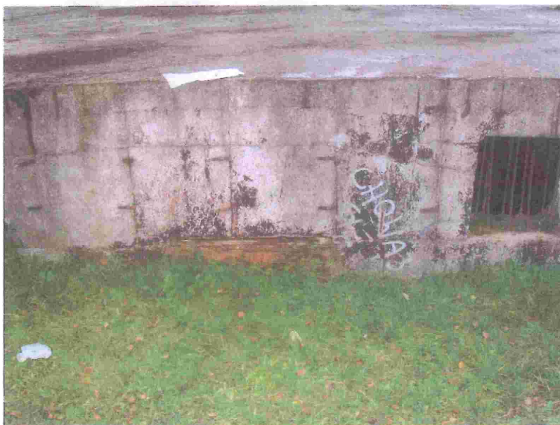
Fot.2 WIDOK ŚCIAN
