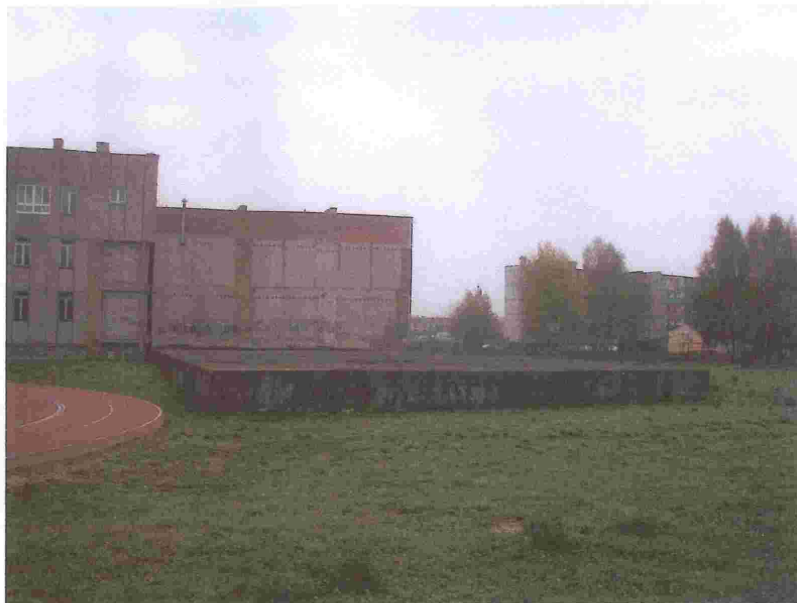
Fot.1 WIDOK KONSTRUKCJI SCHRONU
