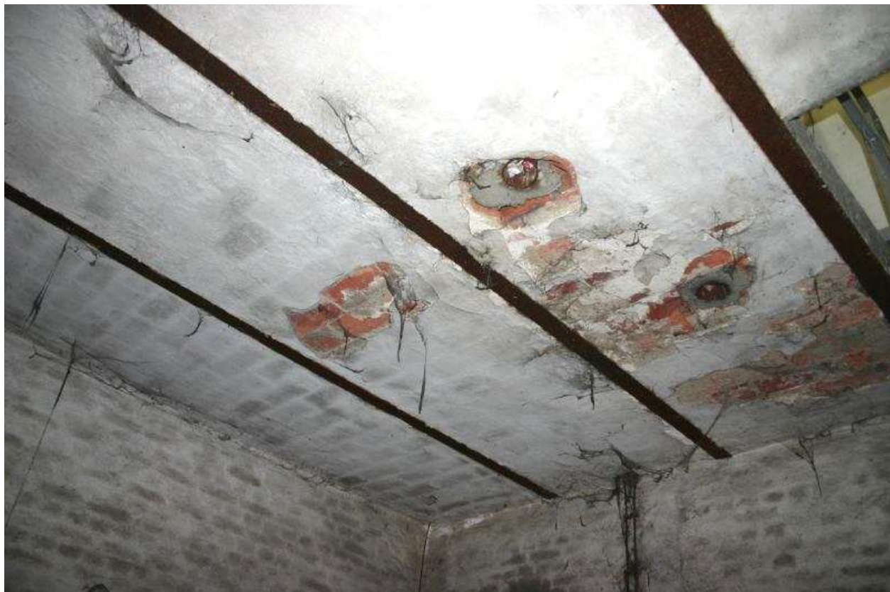
Fot.18 Strop pośredni stalowo-ceramiczny
