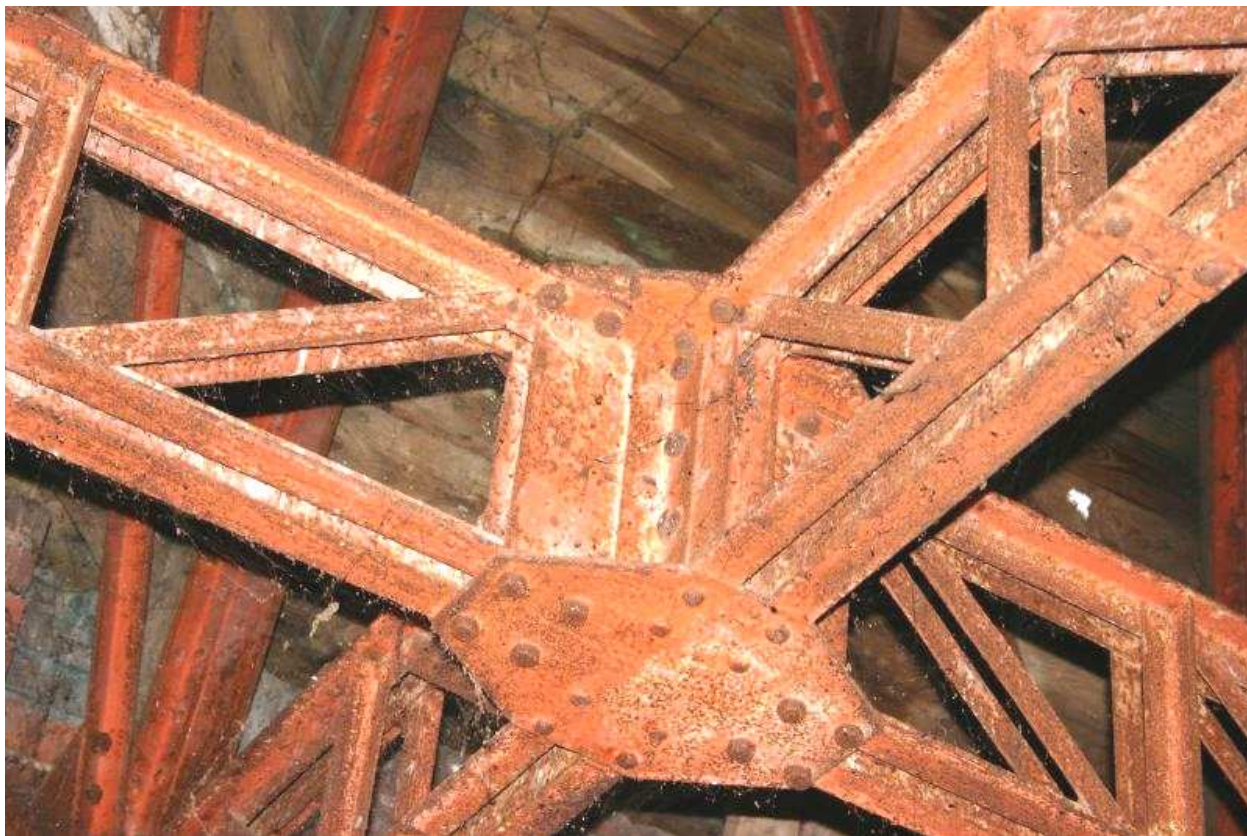
Fot.14 Stalowa konstrukcja nośna dachu wieży
