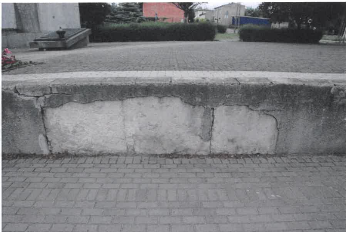
Odparzony tynk z muru oporowego, uszkodzony cokół muru z bloczków betonowych, klawiszowanie płyt betonowych muru oporowego
