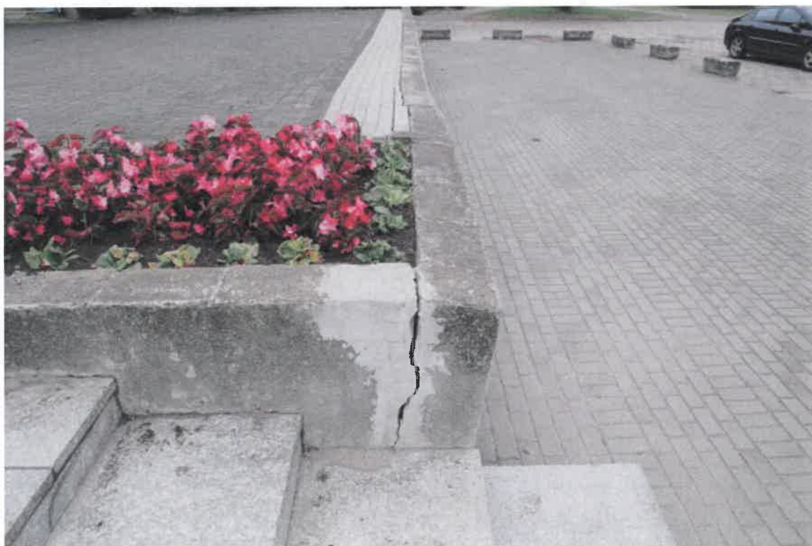
Uszkodzenia i odchylenie od pionu muru oporowego przy wschodnim kwietniku
