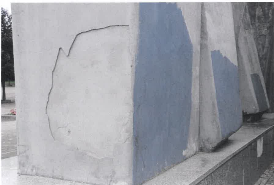
Zamalowania farbą z tyłu pomnika, odparzona zaprawa cementowa na powierzchni bloku zachodniego
