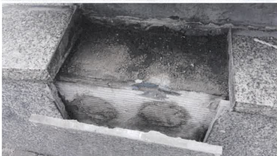
Odkrywki postumentu pomnika od strony tylnej i przedniej, odparzenia płyt granitowych
