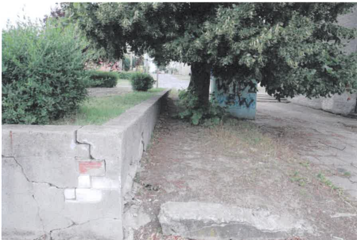
Zniszczony narożnik południowo-wschodni muru oporowego placu
