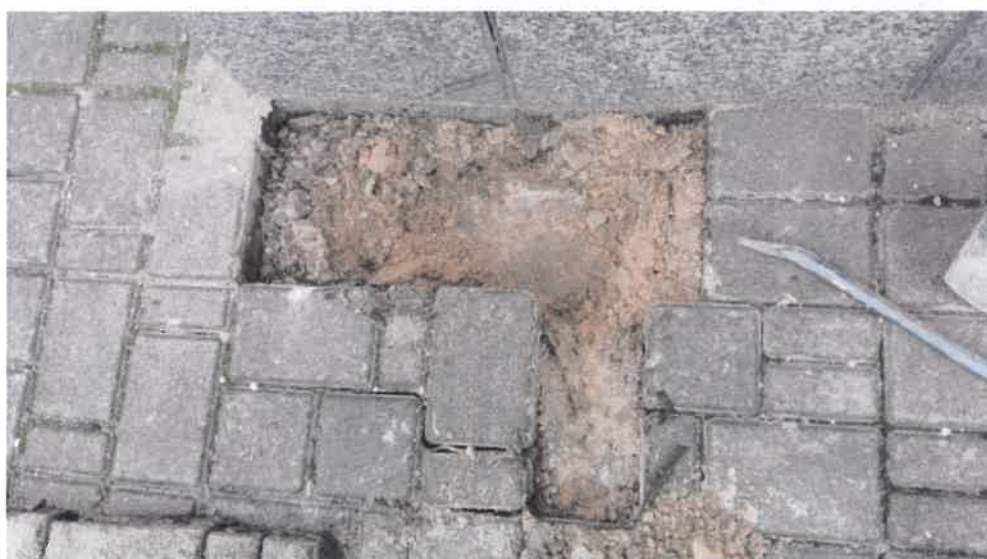
Odkrywka wierzchu fundamentu postumentu, pod kostką betonowy podkład po zdemontowanych płytach chodnikowych
