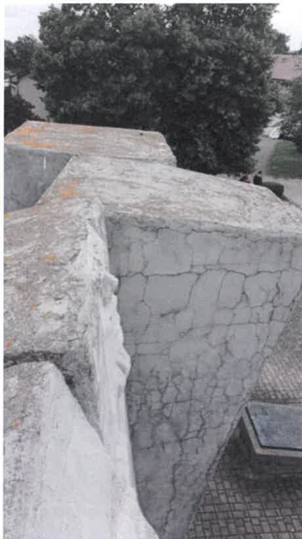
Zawszenie i częściowa erozja powierzchni stropów bloków pomnika
