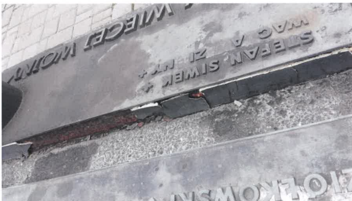
Zardzewiała podstawa mniejszej płyty pamiątkowej na poziomej tablicy pamięci, zacieki stearyny i zabrudzenia na płycie lastryko tablicy pamięci
