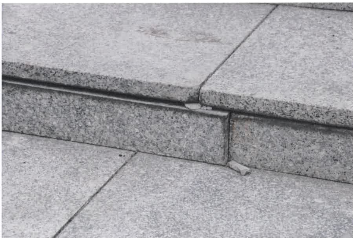
Odparzone i nieszczelnie zamocowane płyty granitowe schodów głównych Placu
