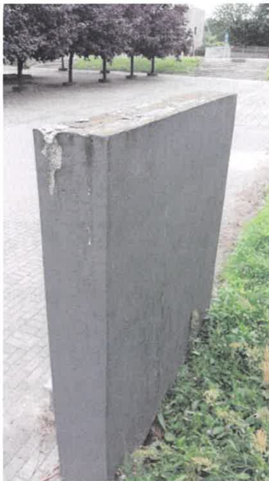
Jedna z trzech tablic pamięci, uszkodzona powierzchniowo od góry, ziemia z roślinnością opsypuje się z przyległego nasypu
