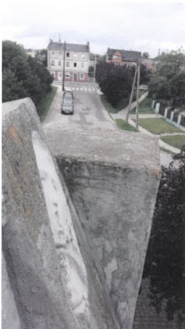
Zawszenie i częściowa erozja powierzchni stropów bloków pomnika
